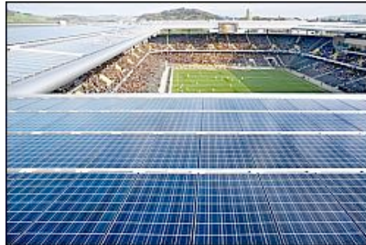
Solarzellen auf dem Dach des Stade de Suisse: Investiert wird auch in alternative Energiequellen. (Bild: Michael Peuckert)
