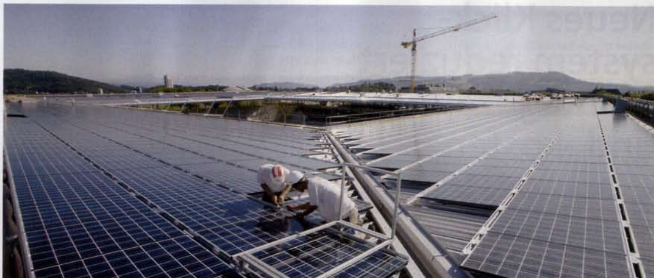
Modulmontage mit dem Klicksystem Montavent auf dem Wankdorf-Stadion in Bern. Die Solarmodule werden an der schmalen Seite in die Montageschienen eingeklickt.
