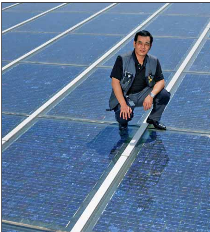
Die erste Schweizer Solarstromanlage mit in Isolierglas integrierten Solarzellen liefert seit 1999 Strom fürs Migros Hochhaus am Limmatplatz.
