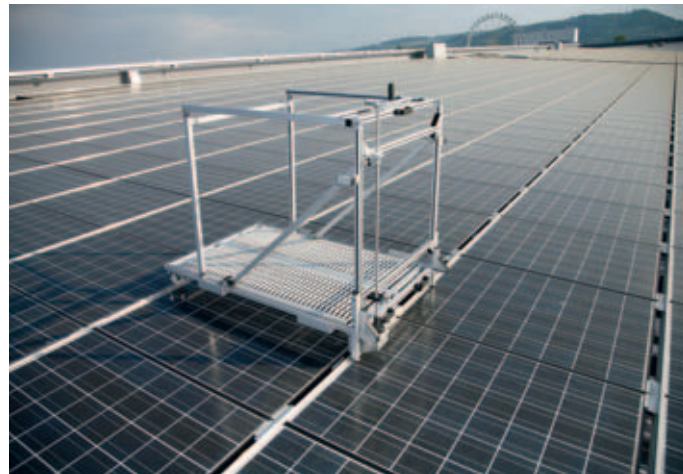
Das Ingenieurbüro energiebüro® aus Zürich stellte einem internationalen Publikum ihre Montagelösungen und Servicegeräte SolarBuggy und SolarDraisine vor, im Bild die SolarDraisine. (Foto: energiebüro®)
