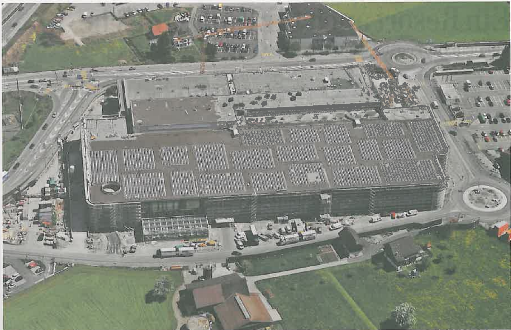
So präsentiert sich die grösste Solarstromanlage der Zentralschweiz aus der Luft.
