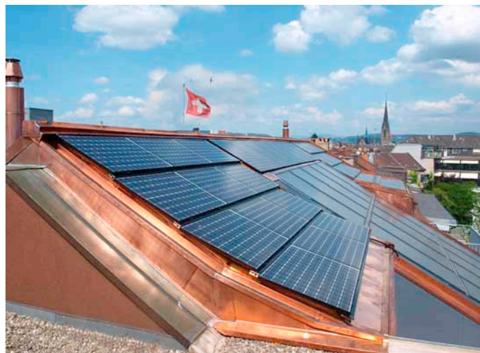
Ziegeldicht verlegte Solarmodule helfen mit, dass bei dieser Altbausanierung in Basel unter Beachtung des Stadtbildschutzes ein preisgekröntes Null-Wärmeenergie-Haus entstanden ist.
