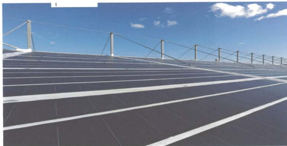
1 So sieht sie aus: Die erste helvetische dachintegrierte Dünnschicht-Photovoltaikanlage.
