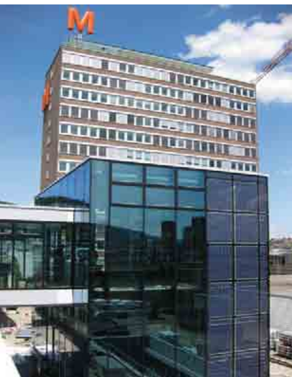
Migros Herderen, Zürich 2009, Doppelnutzung der Solarzellen in Isolierglas als Beschattungselement, Leistung: 38 kWp
