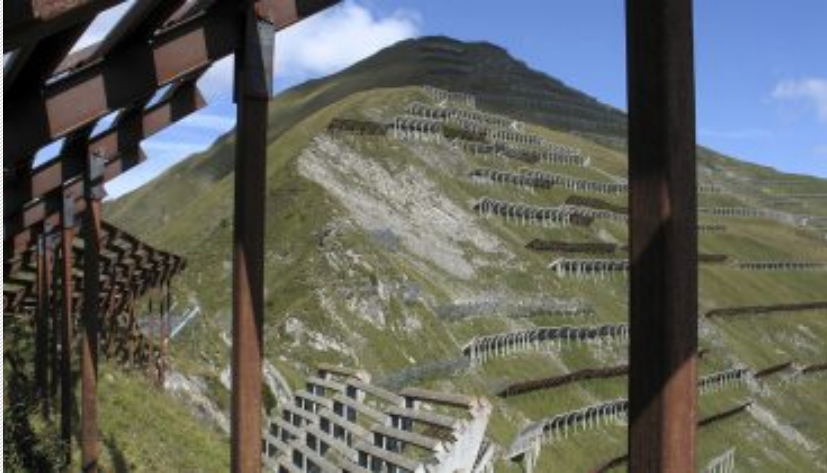
Lawinverbauungen ob St. Antönien in den Bündner Bergen (Bild: NZZ, Adrian Baer)
