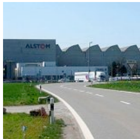
Auf diesen Alstom-Hallen entsteht das neue Sonnenkraftwerk. (Bild: PD)
